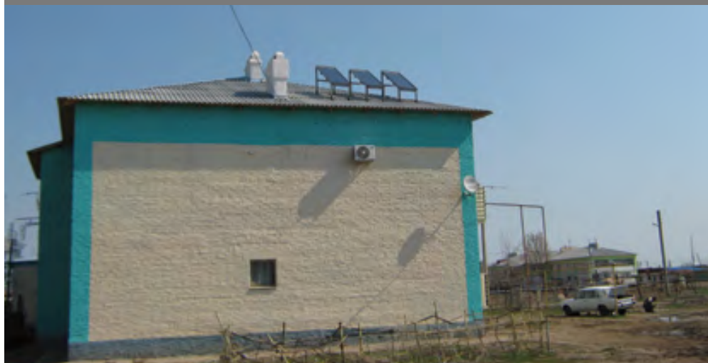
Солнечные батареи поселок Володарский АО-2
