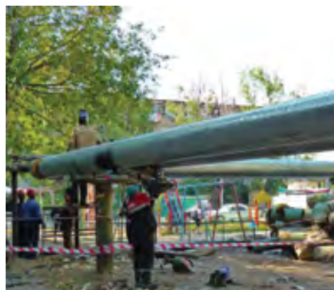
ЛУКОЙЛ-ТТК ремонт теплотрас
