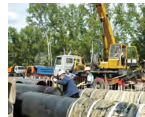
ЛУКОЙЛ-ТТК ремонт теплотрас
