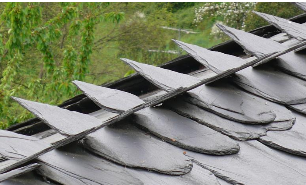
Оригинальный конек крыши, выполненный из сланца
