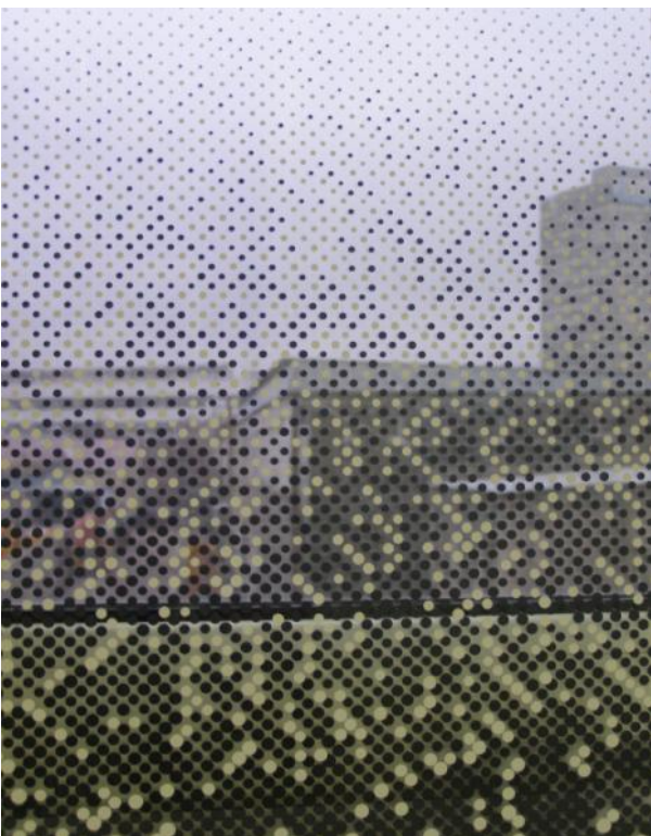
Современное стекло: с цветным принтом (для предотвращения перегрева помещения и проникновения слепящего света) и со встроенными светодиодами
