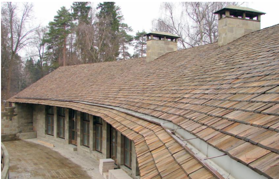
Деревянная кровля частного жилого дома в Подмоскowie
