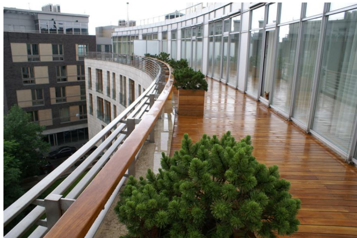
Эксплуатируемая кровля с настилом из тика
